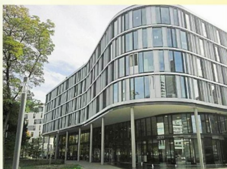
Sonnenschutz für ein extravagantes Bauwerk: Hutterer stattete das Arabeska-Bürogebäude komplett mit Innenrollos aus.
